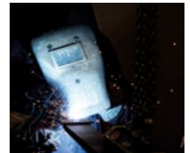
Abb.: Schweißarbeiten zur Vorbereitung von beschichteten Gabelzinken
